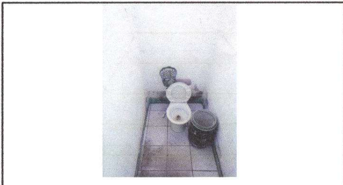
Foto 3: Inodoros en mal estado.
