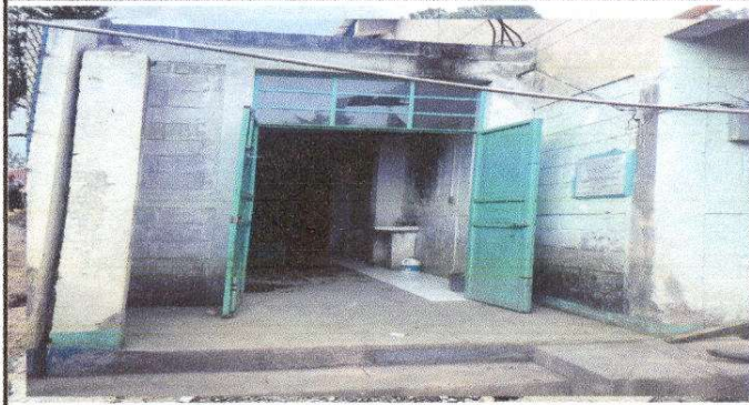
Foto 1: Paredes húmedas sin repello.
